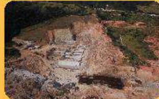
Visão geral da obra. Data: 14/05/22
