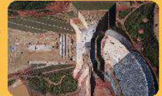
Visão geral da obra. Data: 14/05/22
