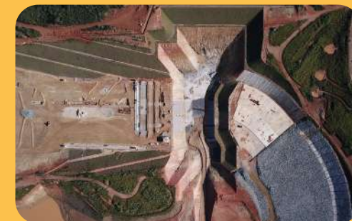
Visão geral da obra. Data: 14/05/22
